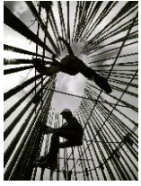
+ Juara Favorit (Red Construction - Hasiholan Siahaan)
