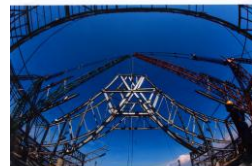
Nominator (34) - (Memasang Rangka Atap - Gunawan Rustandi)
